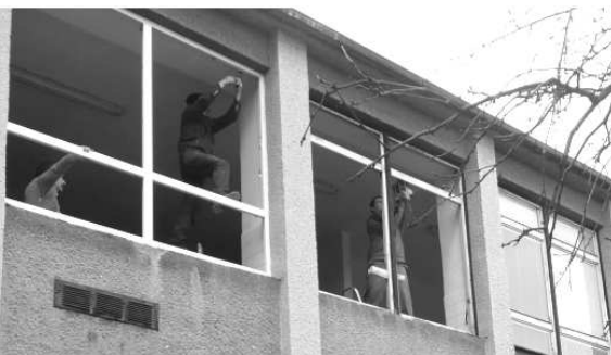
Minulý týždeň sa na škole začalo s výmenou okien
