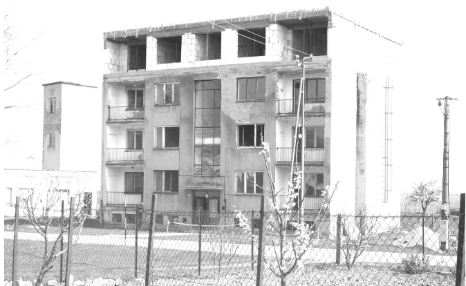
Rekonštrukčné práce na bývalej družstevnej dvanásťbytovke sa už začali.
