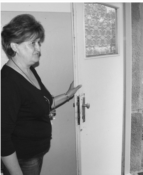
Riaditeľka ZŠ a MŠ vo Vrbovke Mgr. Z. Alakšová ukazuje poškodenie dverí na zadnom vchode, kadiaľ sa zlodějom pravdepodobne podarilo dostať do budovy školy.
