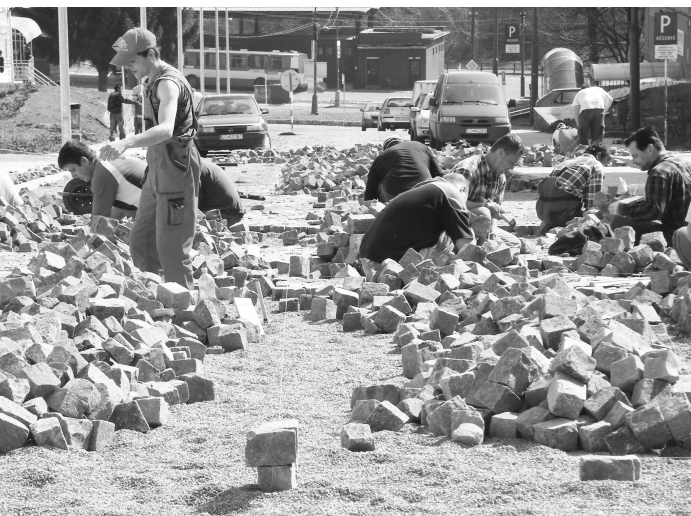
Asi sa znovu rozozvučia kladivká dlaždičov pri oprave Štefánikovej ul., s kvalitou ktorej, hlavne jej hornej časti, nie sú spokojní občania ani vedenie mesta.
