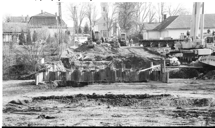
Zatiaľ stojí pontónový most, ktorý bude slúžiť pre účely stavbárov.
